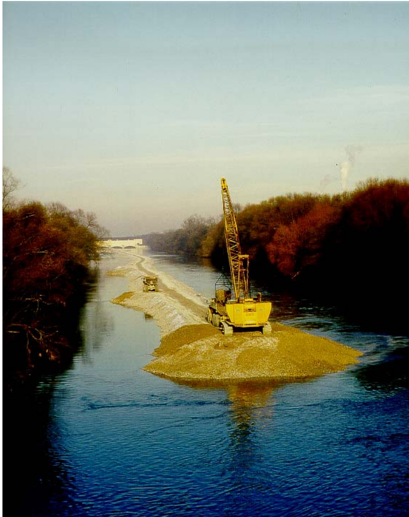
Bild: mechanische Räumung des Stauraumes am Oberföhringer Wehr, Kampagne 1995/96
