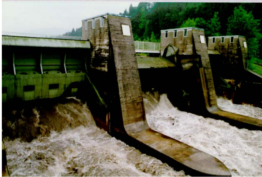
Bild: Stauraumspülung, Wehr der Staustufe Bad Tölz ( 17.07.1997 )
