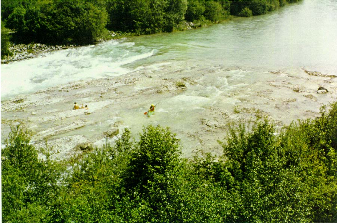
Bild: Beispiel einer naturnahen Sohlrampe
