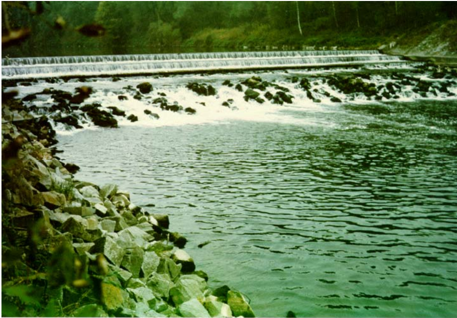
Bild: Acheringer Sohlstützwehr bei Fkm 120,4 ( Zustand von 1989 )
