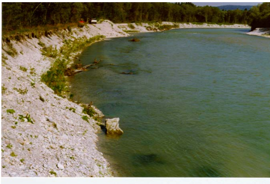
Bild: Uferrückbaumaßnahme unterhalb des Ickinger Wehres (Pilotvorhaben, 1998 )
