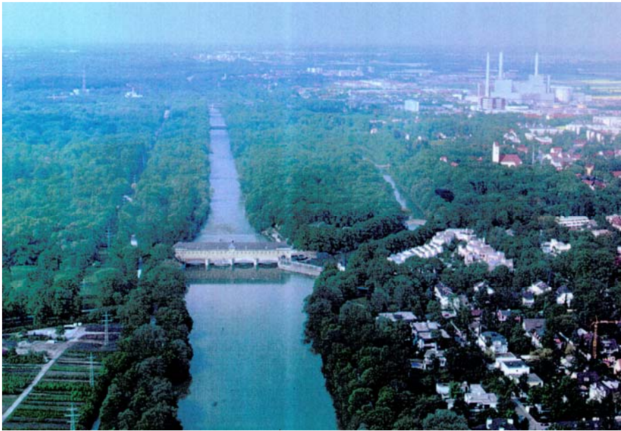
Bild: Beispiel für Verlust an Geschiebedurchgängigkeit und Restgeschiebefracht für den anschließenden Flußlauf
