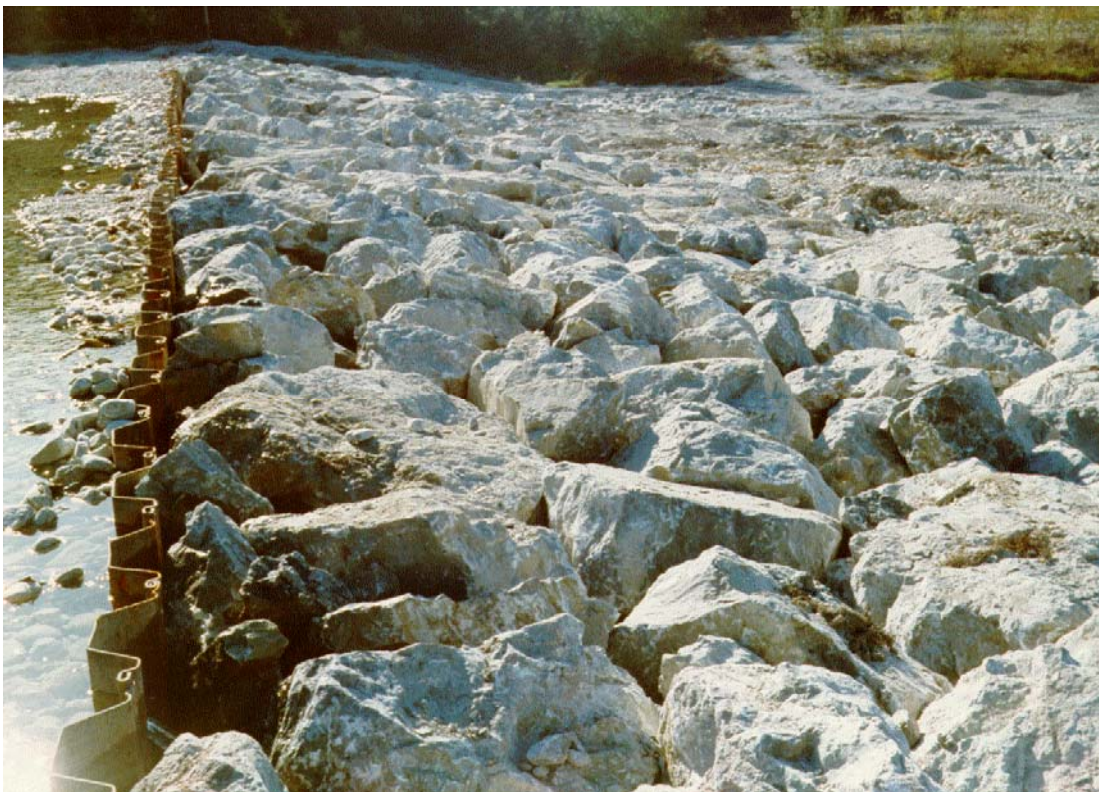
Bild: Sohlstützende Querbauwerke in Steinrampenbauweise
