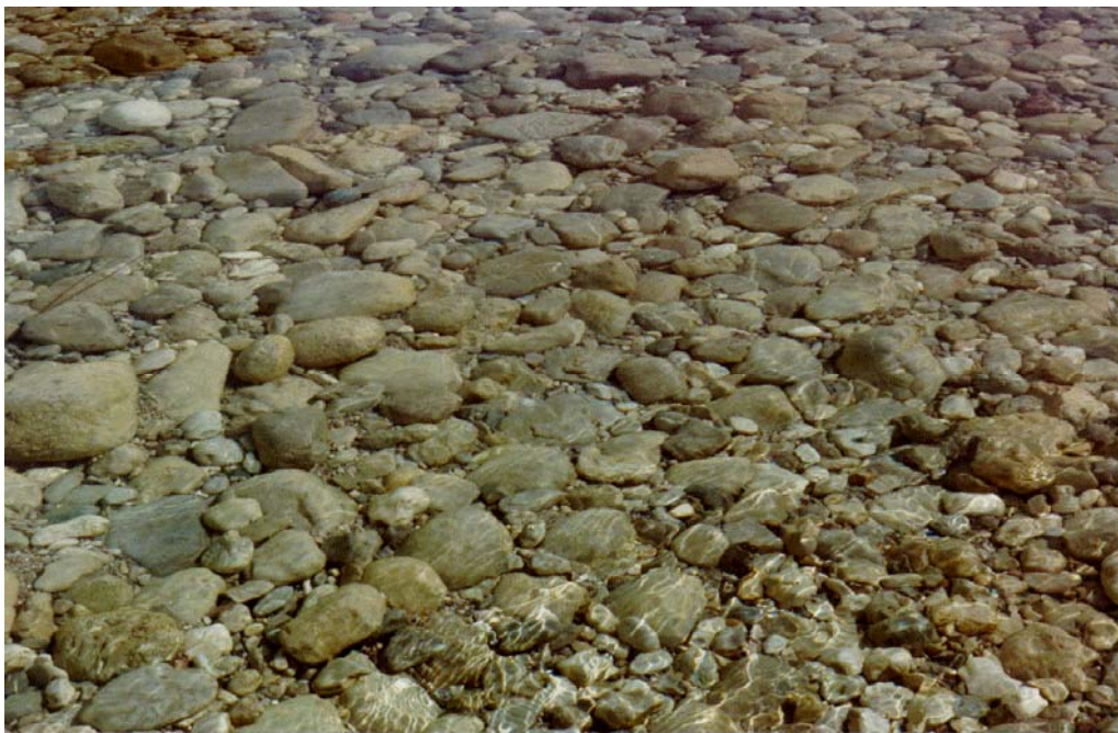
Bild: Sohlstabilisierendes Deckwerk
