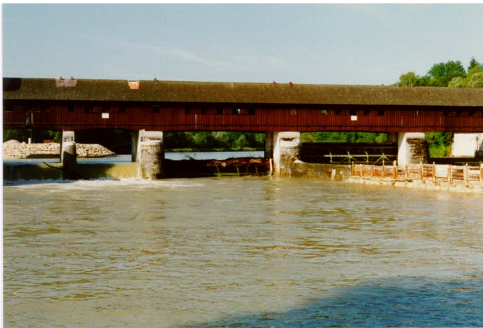
Bild: Wehranlage Icking, vom Unterwasser, 1997
