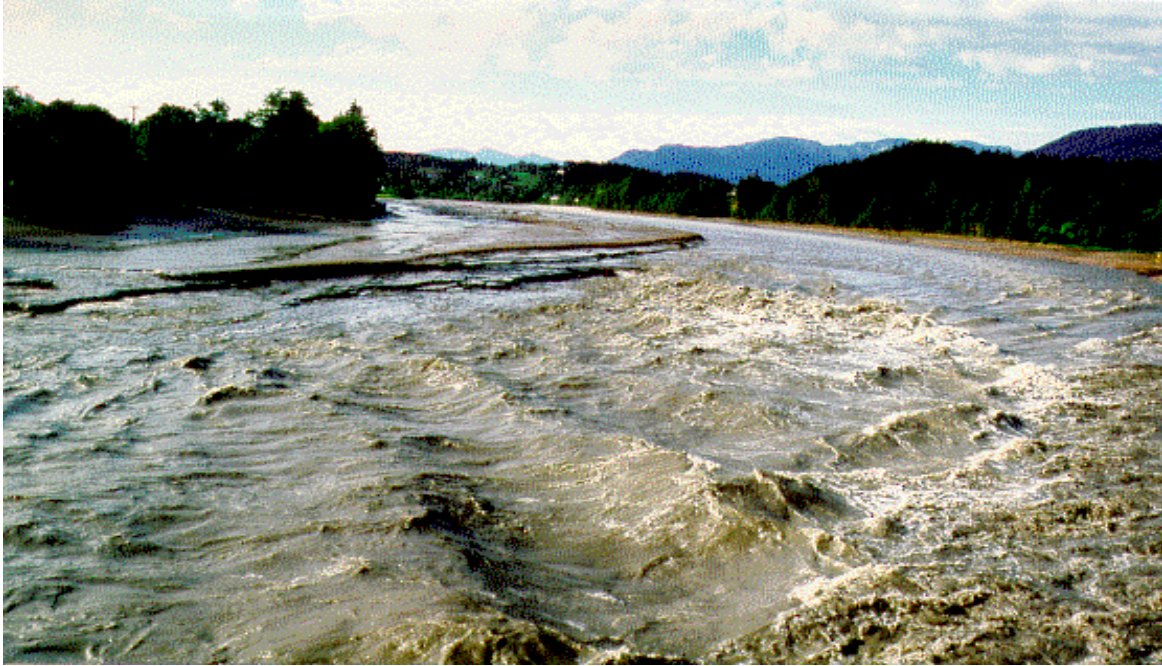
Bild: Stauraumspülung Staustufe Bad Tölz bei mittlerem Hochwasser, 16.07.1993
