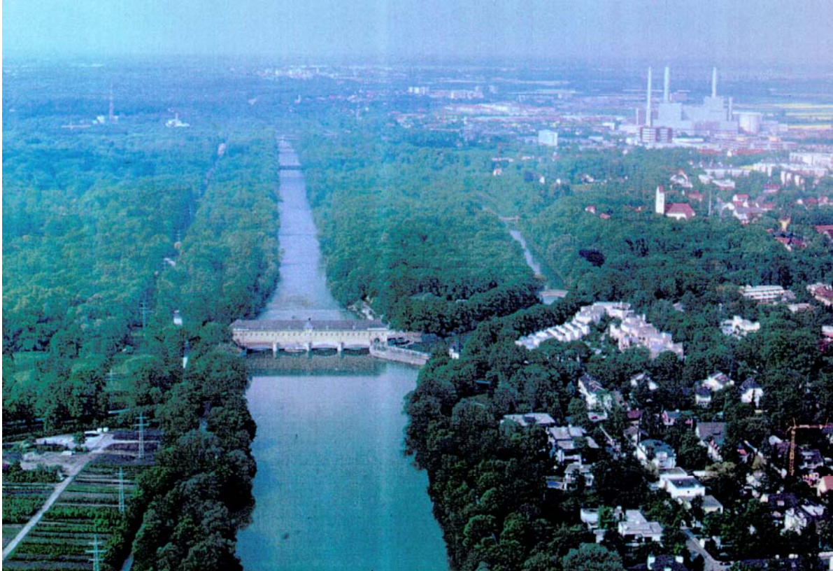
Bild: Blick auf die die Wehranlage Oberföhring ( mit Teil des Stauraumes, rechtsseitig Ausleitung des Miag-Kanals ) sowie die Isar flußabwärts (Teil der Wiebeking'schen Flußkorrektion)
