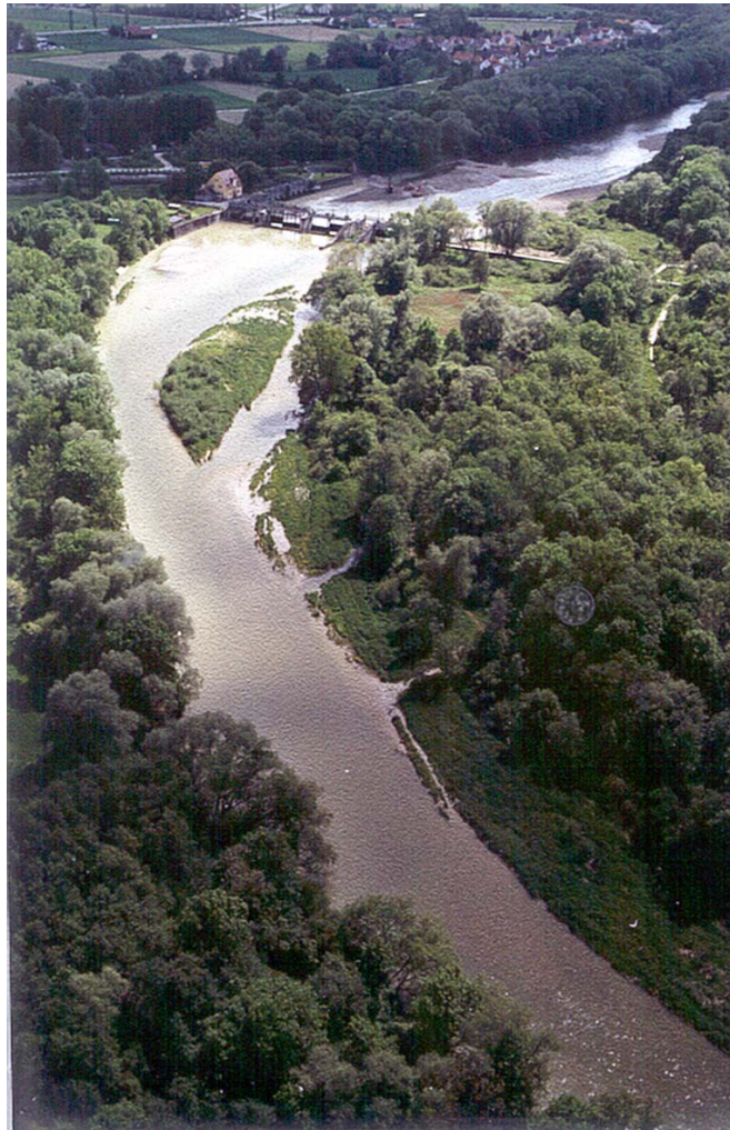
Bild: Blick von Unterwasser gegen das Moosburger Wehr, links im Oberwasser Kanaleinlauf und Geschieberäumung
