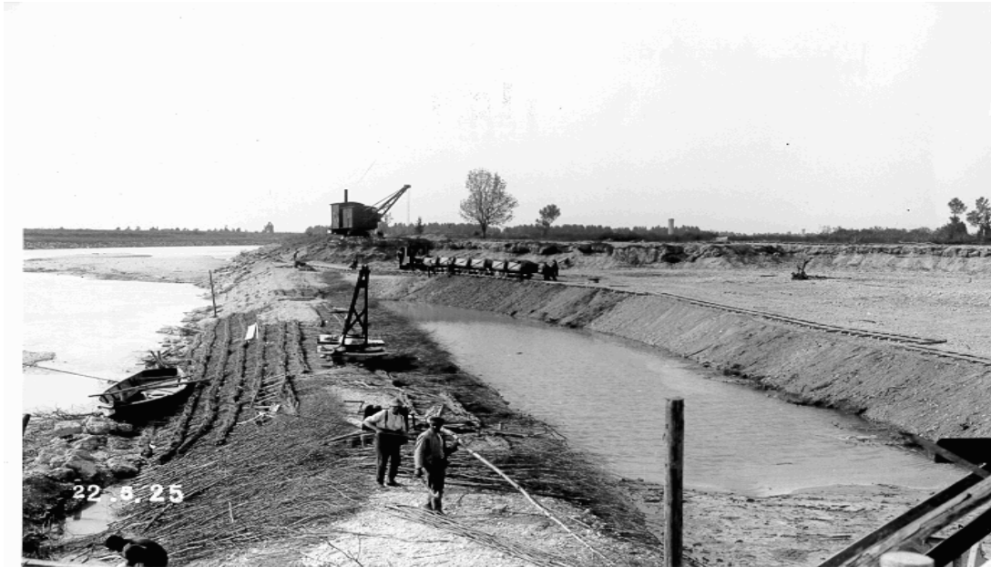
Bild: Mensch und Flußkorrektur - Baustelle einer Flußkorrektur ( Lech 1925 )
