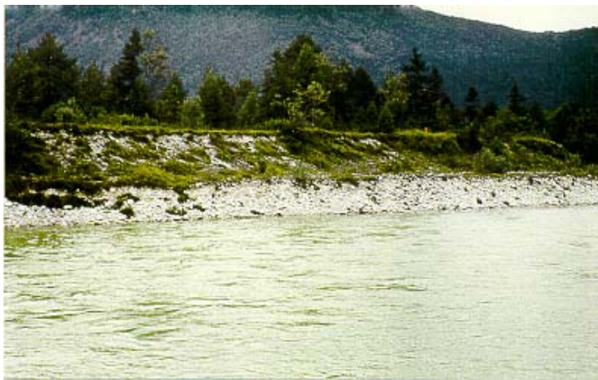
Bild: Die Höhe des Bruchufers gibt die in der Hauptsache etwa seit 1920 zustande gekommene Eintiefung wieder. Die Höhe der unteren Eintiefungsstufe dürfte etwa der Eintiefung seit den 60 iger Jahren entsprechen. ( Isar 1984, Fkm 216,3, unterhalb Flecker Wehr )
