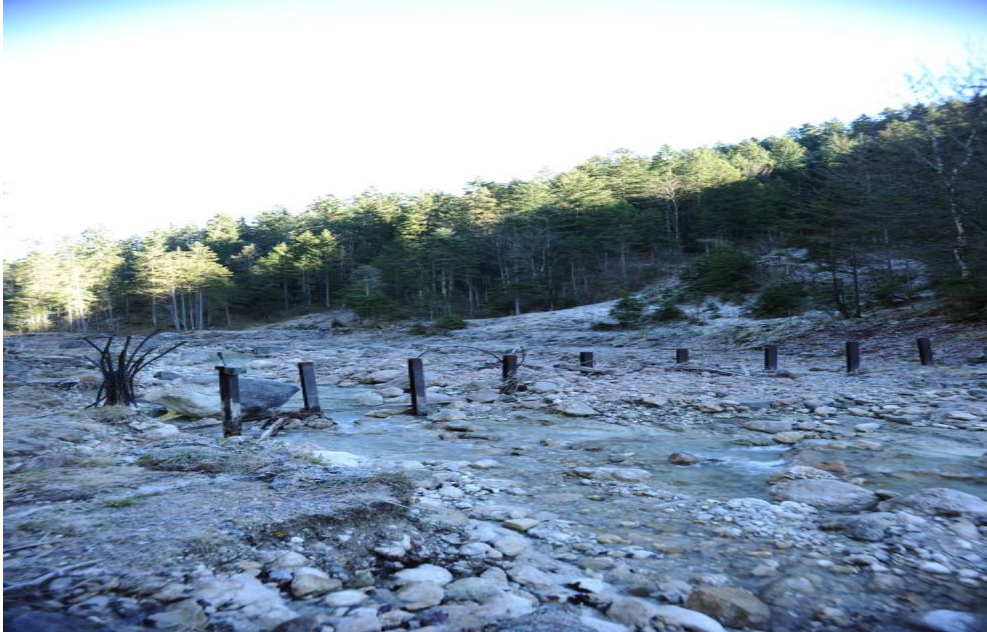
Abbildung 4.3: rechenähnliche Querverbauung im Arzbachtal
