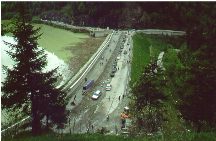
Abb. 7: Bauzustand des Dammes beim Pfingsthochwasser
