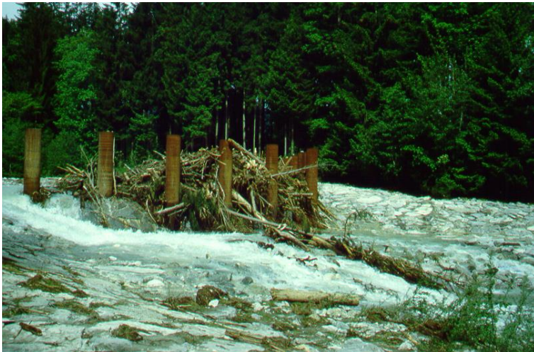
Abb. 27: Treibholzrechen am Arzbach nach dem Pfingsthochwasser
