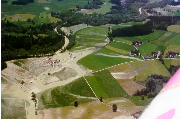
Abb. 30: Deichbruch am Berghof/Peißenberg
