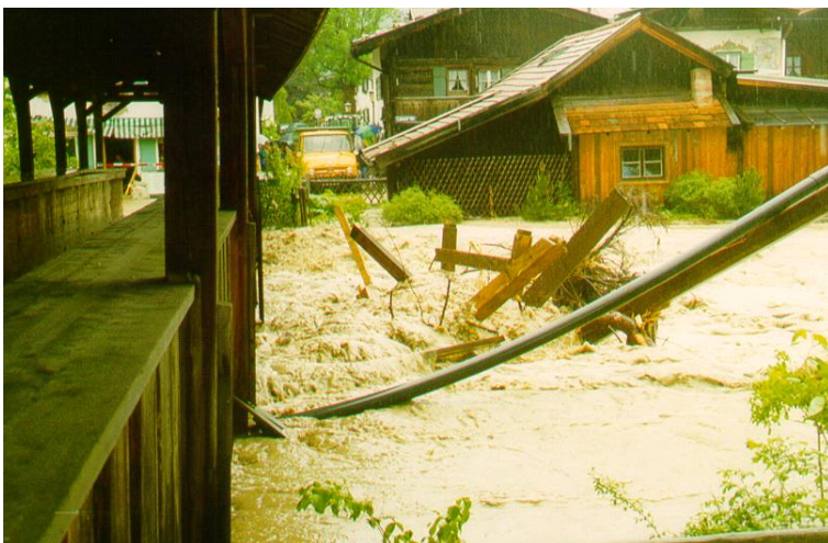
Abb. 19: Loisachhochwasser in Garmisch-Partenkirchen, Schneggensteg
