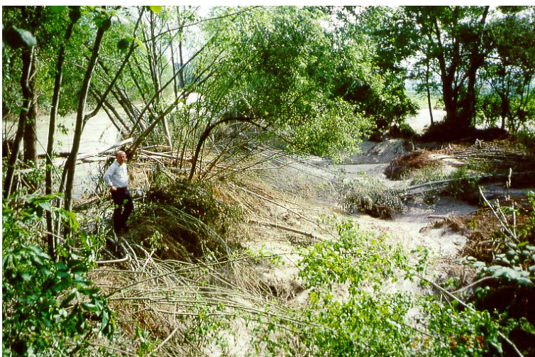
Abb. 17: Deichbruch an der Ammer
