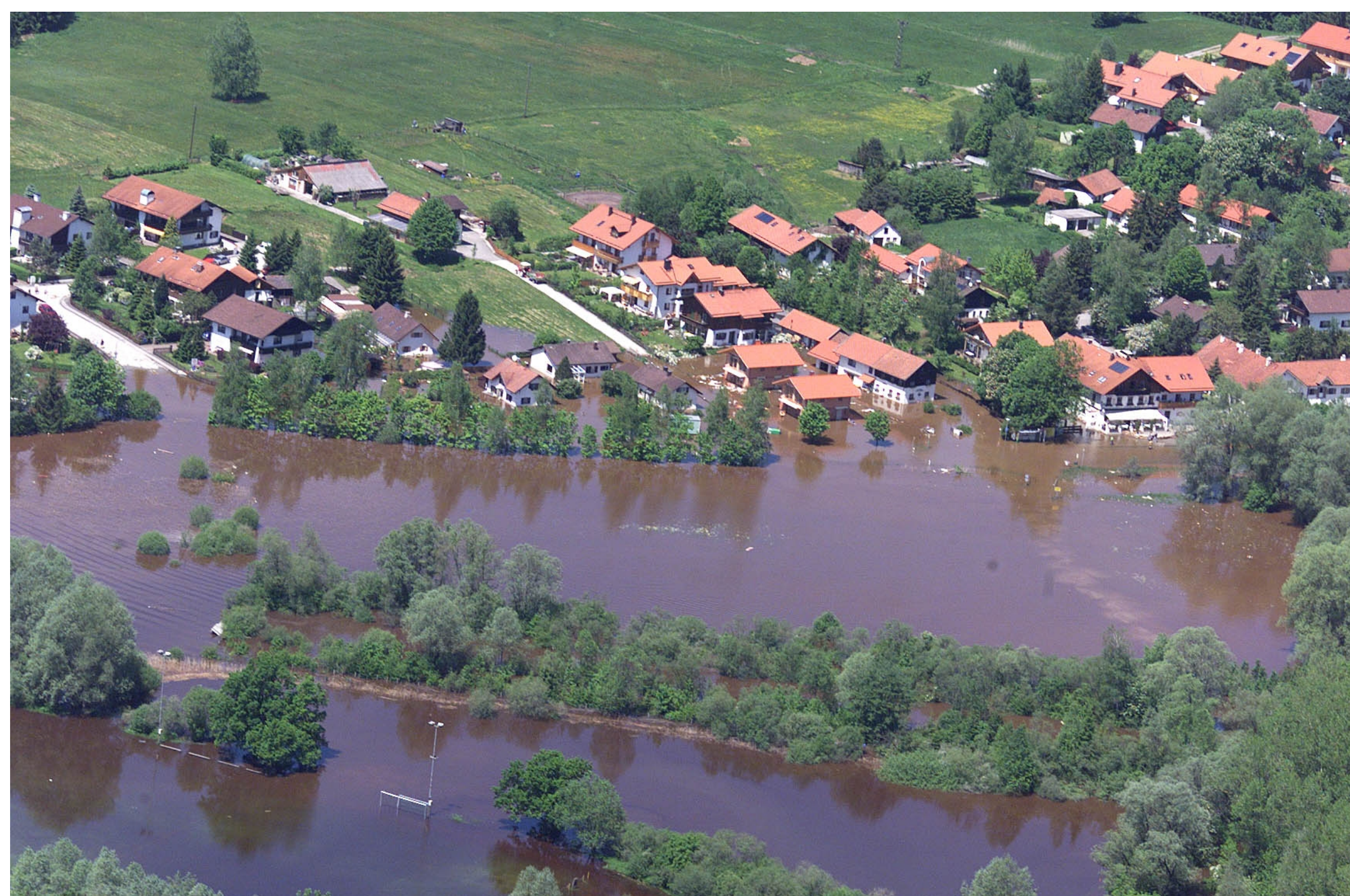
Überflutete Flächen infolge zurückgestautem Binnenwasser
