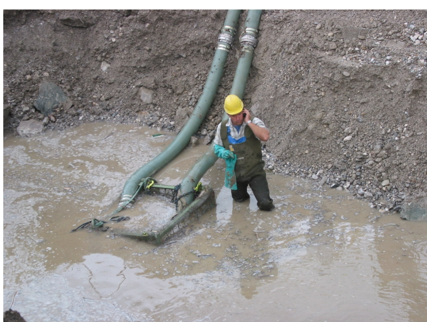
Vorarbeiter Markus Kotzbauer
