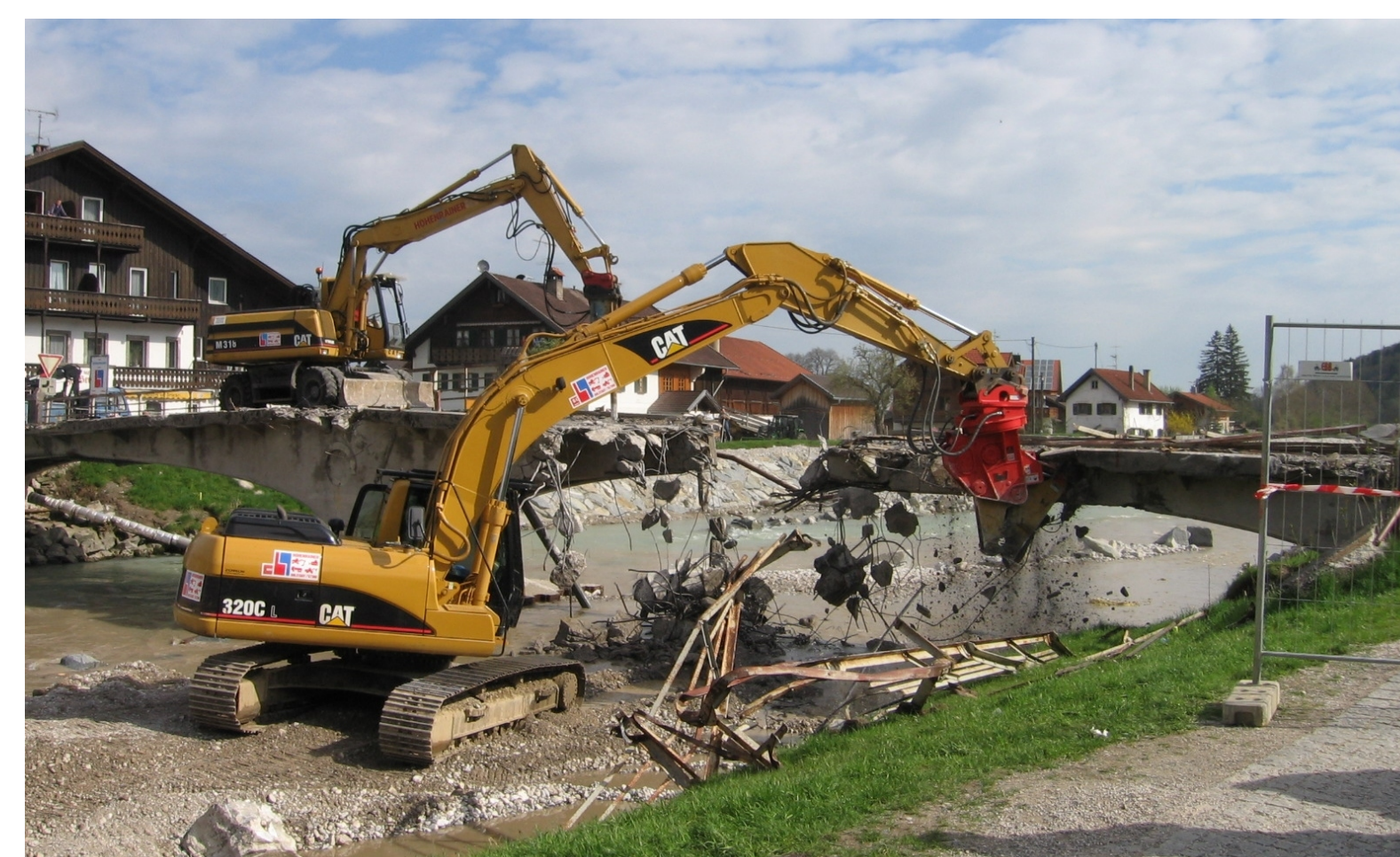
Abbruch Brücke Mai 2006
