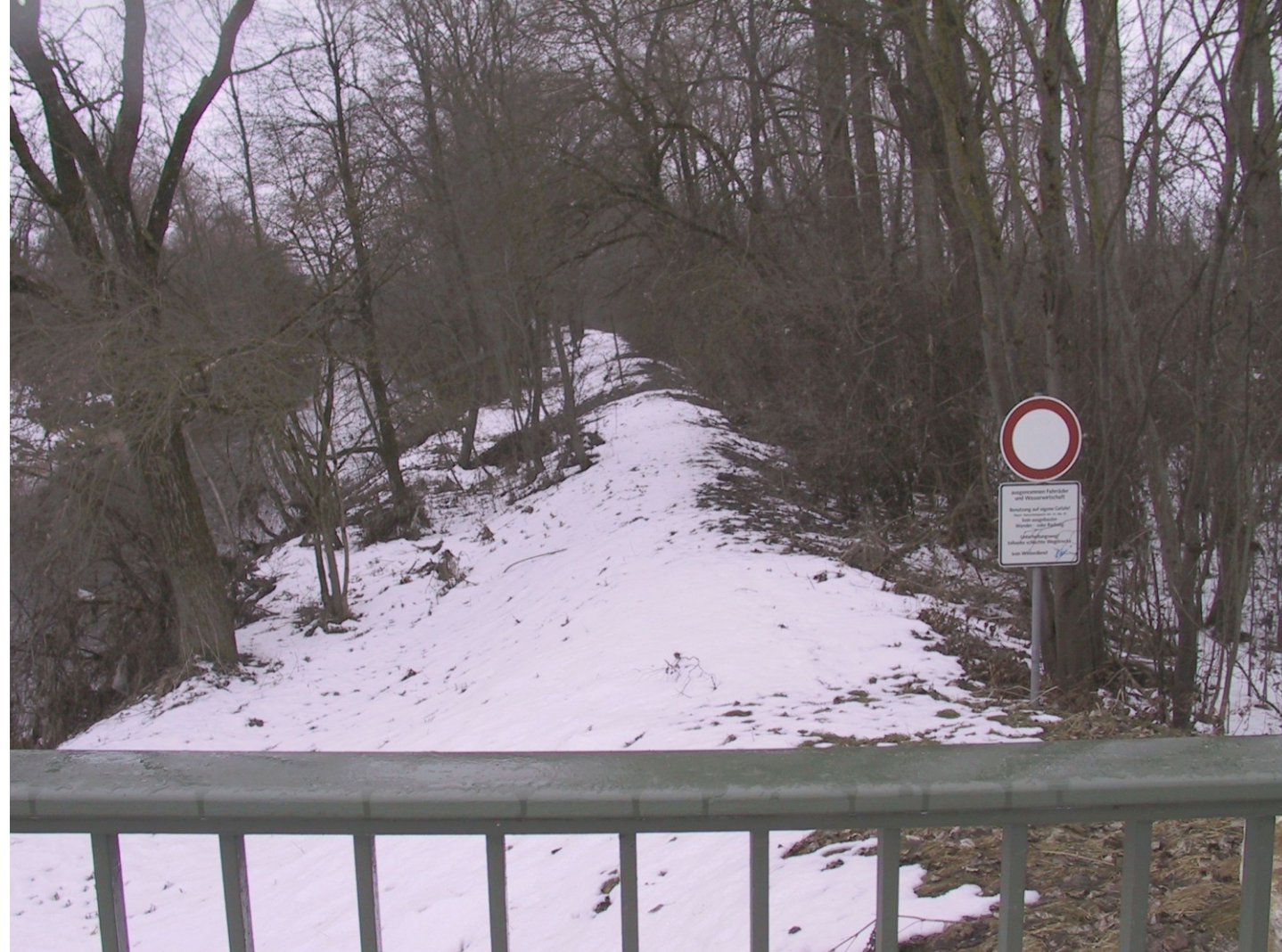
Bild 1: Deich an der Wielenbacher Brücke vor der Sanierung
