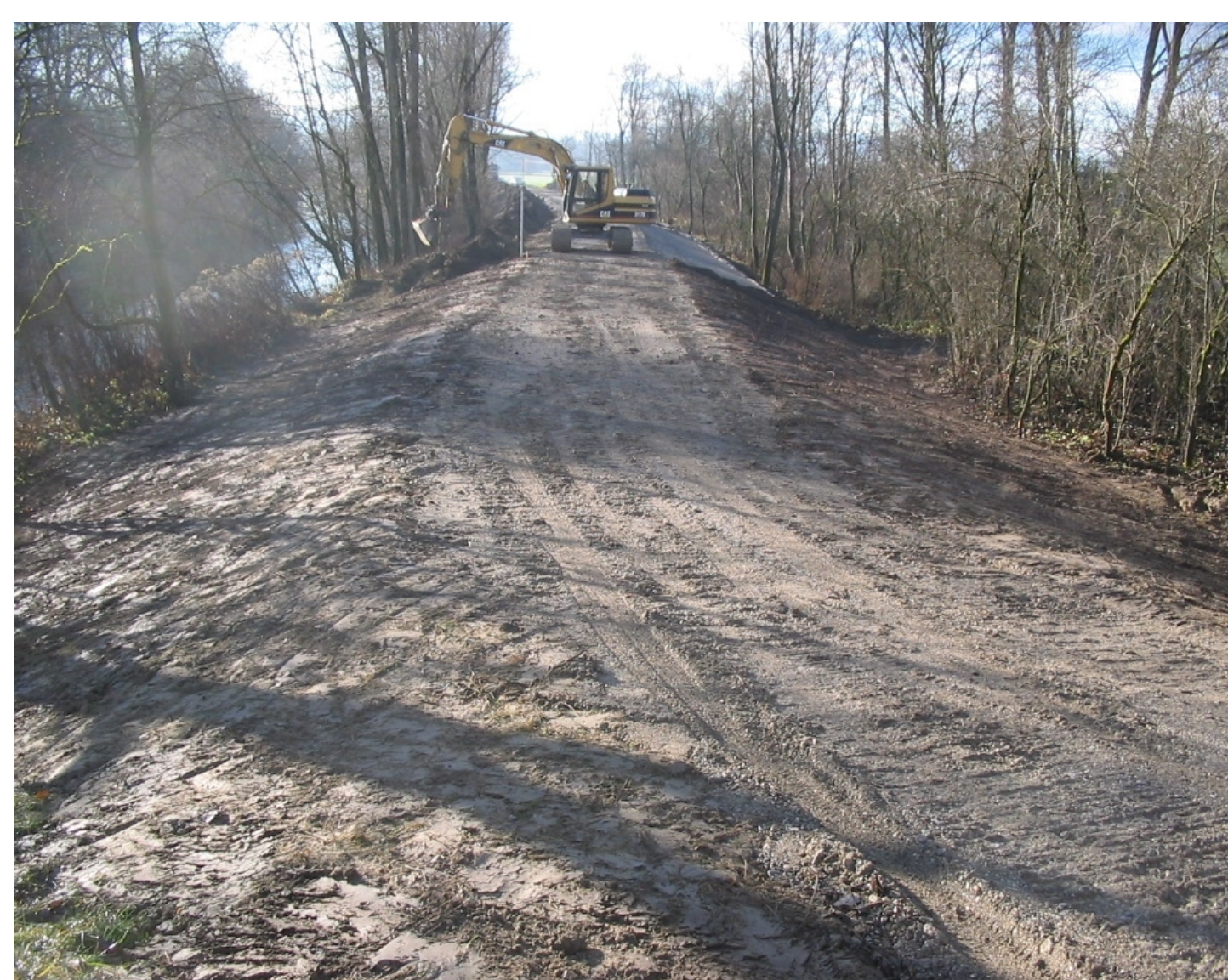
Bild 5: Deich kurz vor Fertigstellung der Sanierung
