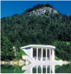
Bild 1: Einlaufbauwerk der neuen HWE
