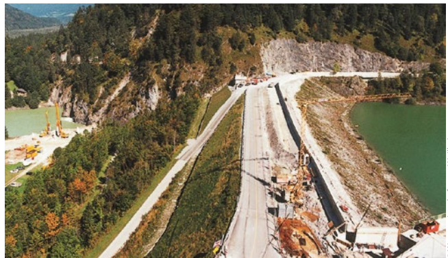
Bild 4: Bau der Kronenmauer und Schüttung des erhöhten Dammbereichs
