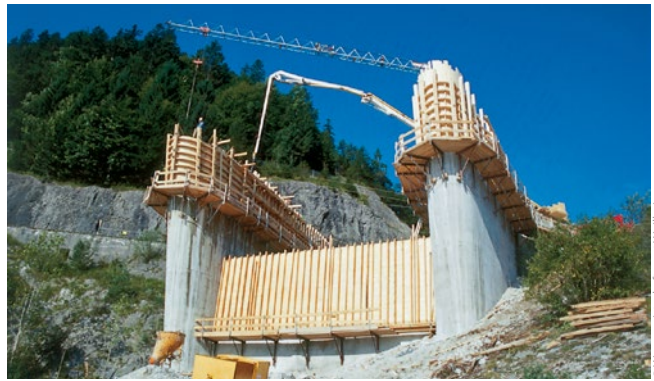
Bild 3: Einbau der Einlaufschwelle und Pfeilererhöhung an der alten HWE
