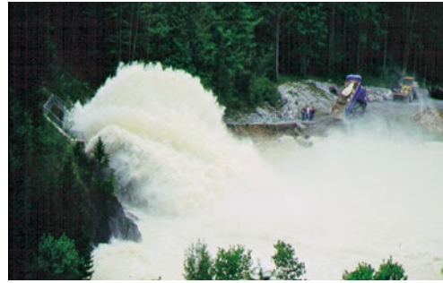
Bild 2b: Neue HWE: Erster Einsatz der neuen HWE mit 260 m 3 /s über die Sprungschanze am 23.05.1999
