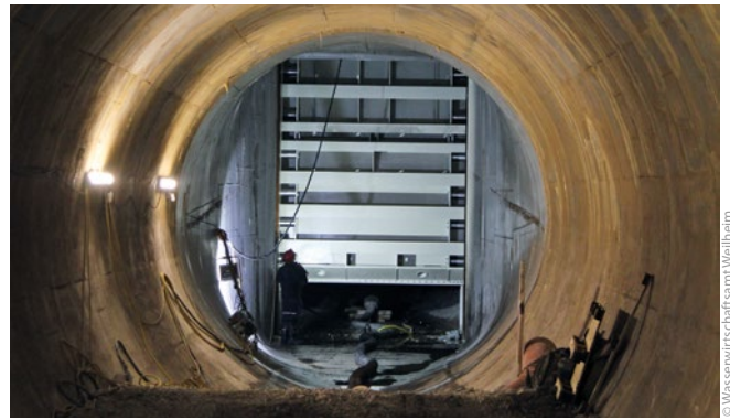
Bild 6: Erneuerung des Stahlwasserbaus, Ober-Schütz im Grundablass
