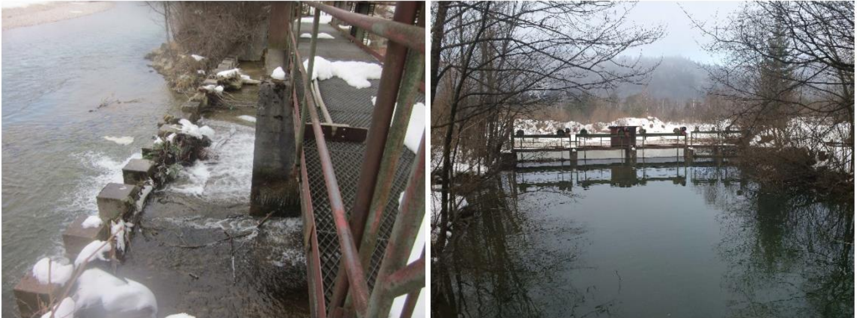
Stauanlage im Mündungsbereich der Großen Gaißach - Bestand
