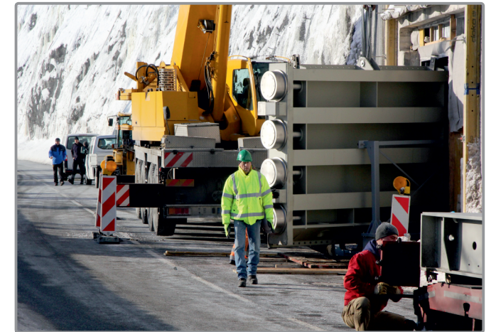
Einbringen einer Schütztafelhälfte in die Grundablasskaverne
