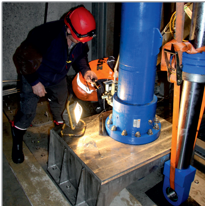
Montage der neuen Hydraulikzylinder
