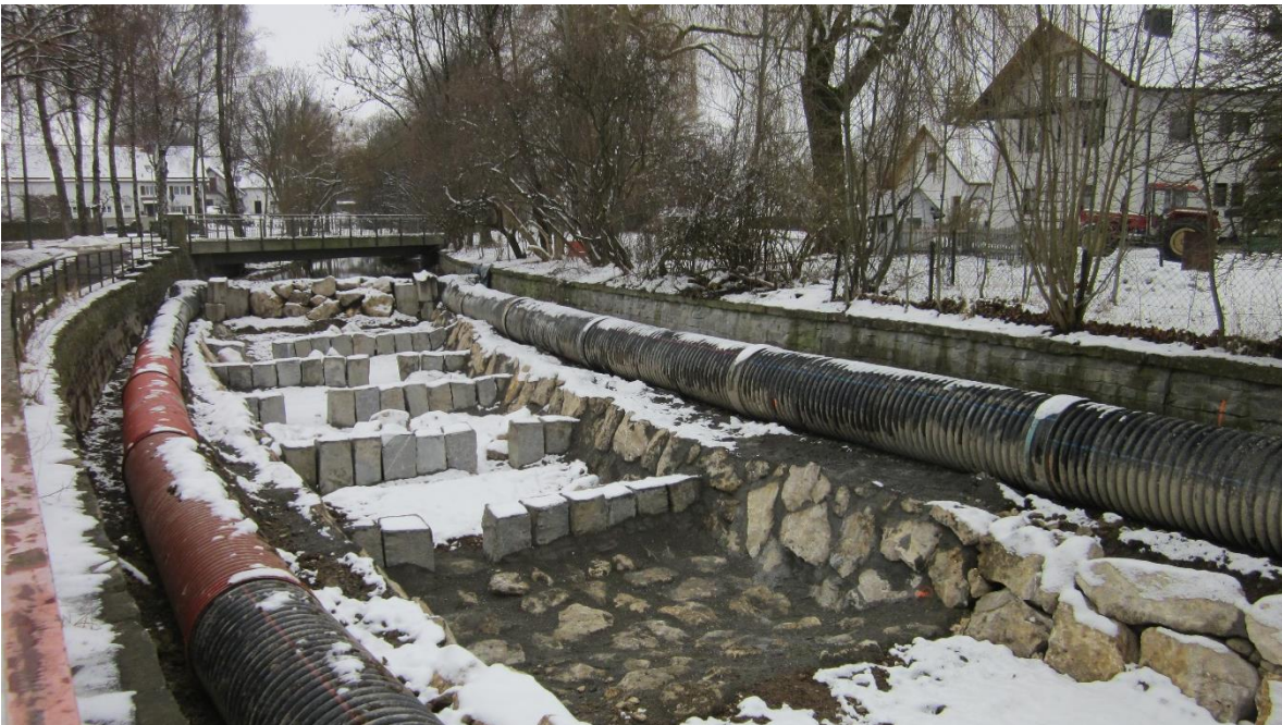
Abbildung 3: Bau der Riegelrampe im Januar 2020 (Quelle: WWA WM)
