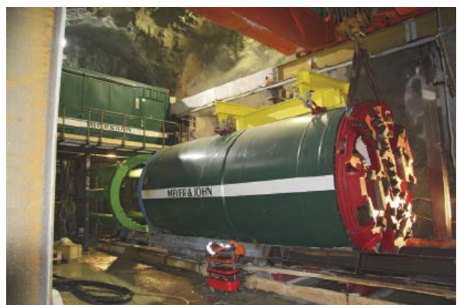
Abb. 6: Montage der Tunnelbohrmaschine (TBM) auf der Schildwieg, dahinter Presseneinrichtung mit 6 Hydraulikzylindern für 2500 t Schubkraft, darüber Steuerstand für den Vortrieb
