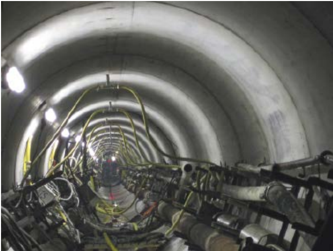
Abb. 7: Stollenvortrieb, Laser, Transport- und Versorgungsleitungen. Die Bentonit-Injektion zur Reduzierung der Mantelreibung erfolgt über die gelbe Injektionsleitung an Firste und Ulmen
