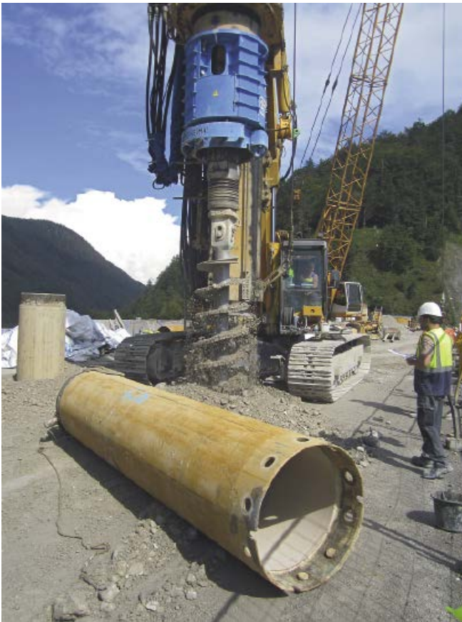
Abb. 9: Bohrpfahlerstellung mit Rohrtour und Bohrschnecke
