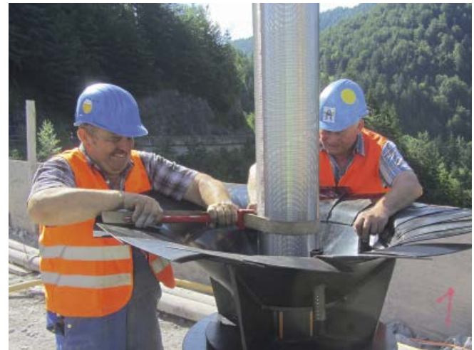
Abb. 10: Vorbereitung zum Einbau des Filters (Schlitzbrückenfilter und Sumpfrohr)
