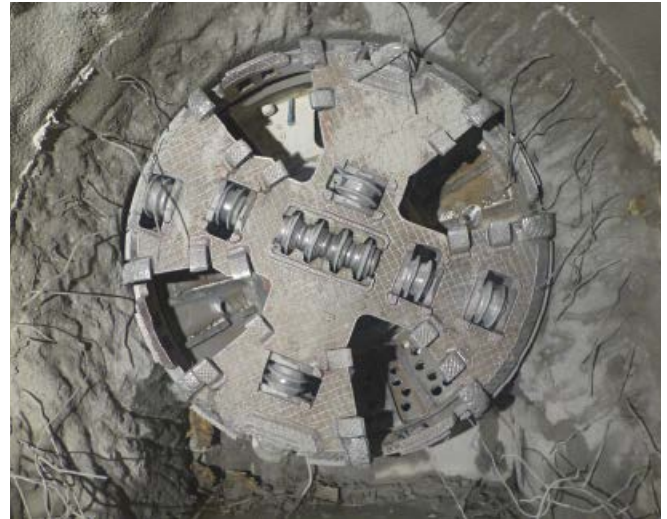
Abb. 8: Bohrkopf der TBM in der Zielkaverne nach Durchörterern der rund 190 m langen Stollenstrecke
