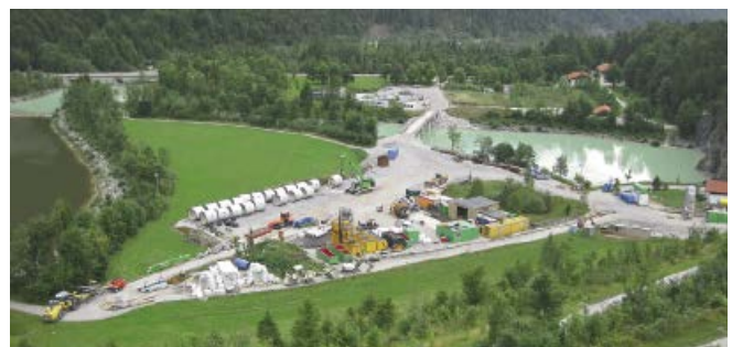
Abb. 5: Neue Brücke über den Kolksee, Baustelleneinrichtung und Rohrlager am Fuß des Sylvensteindamms
